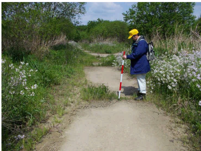
園路の土砂堆積（益田市飯田町）
