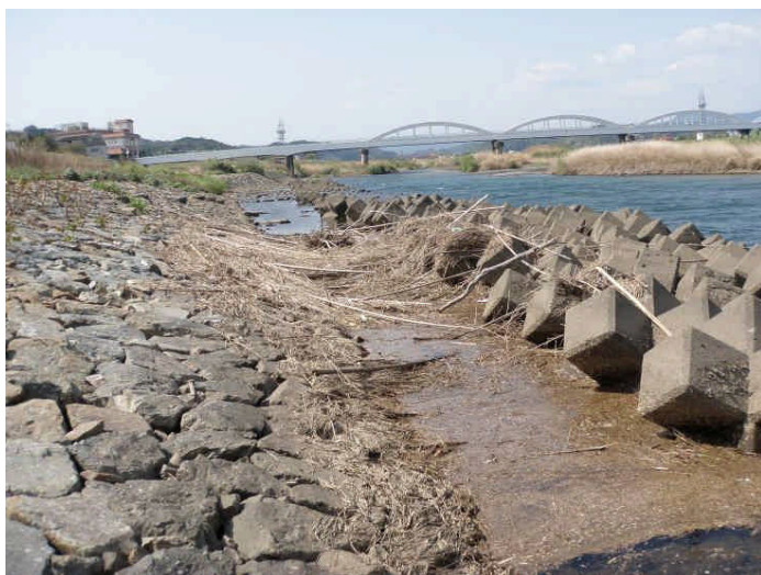
河道内の流木堆積（益田市須子町）
