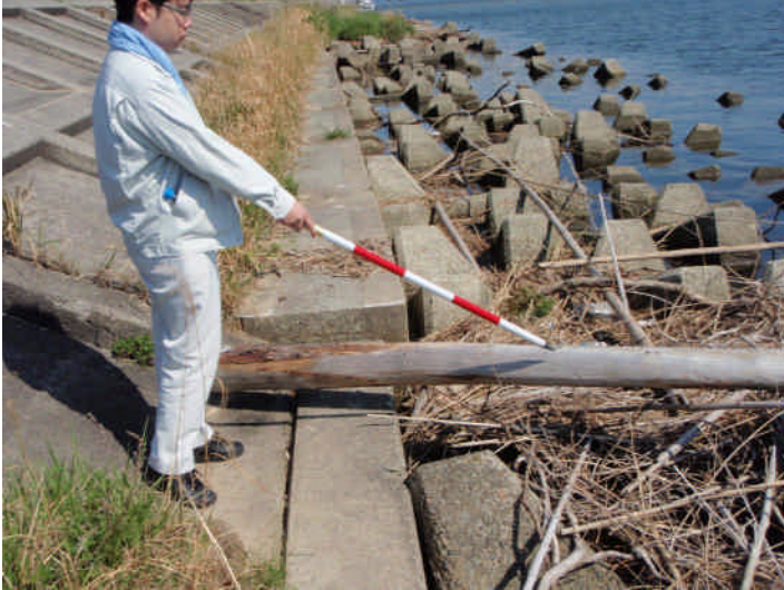
河道内の流木堆積（江津市江津町）
