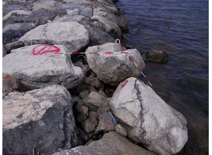
捨石の隙間（益田市高津町）
