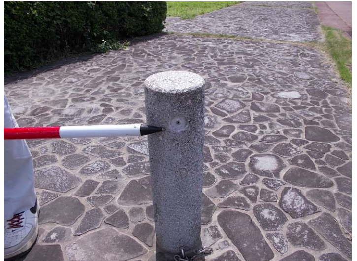
車止めに反射材無し（益田市虫追町）
