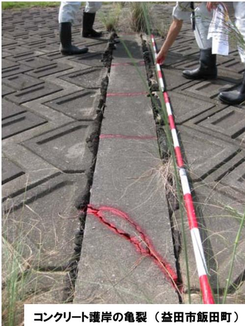
コンクリート護岸の亀裂（益田市飯田町）
