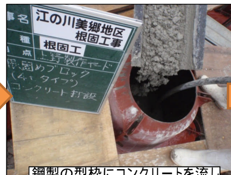
鋼製の型枠にコンクリートを流し込んでいきます。
