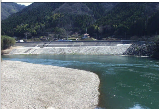
木路原親水護岸が完成した当時
