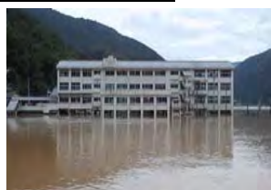
H26.8避難所2階の浸水 (徳島県)
