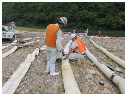
水漏れの点検
