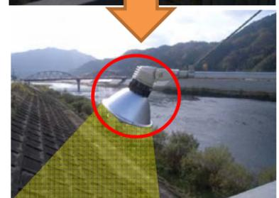
洪水時の樋門操作に支障がないよう点検により不具合が発見された電気部品を交換しました。
