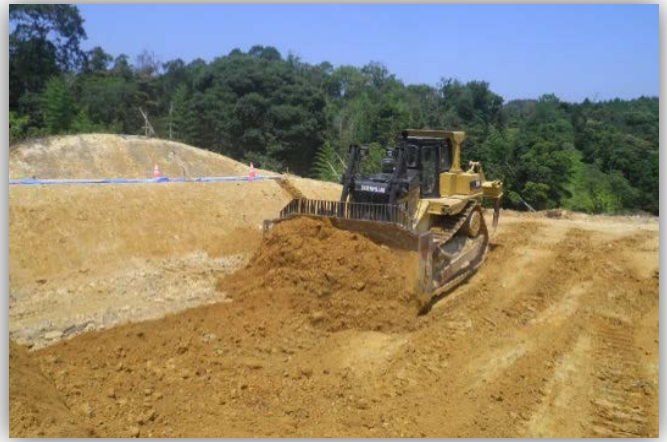
工事現場の状況
