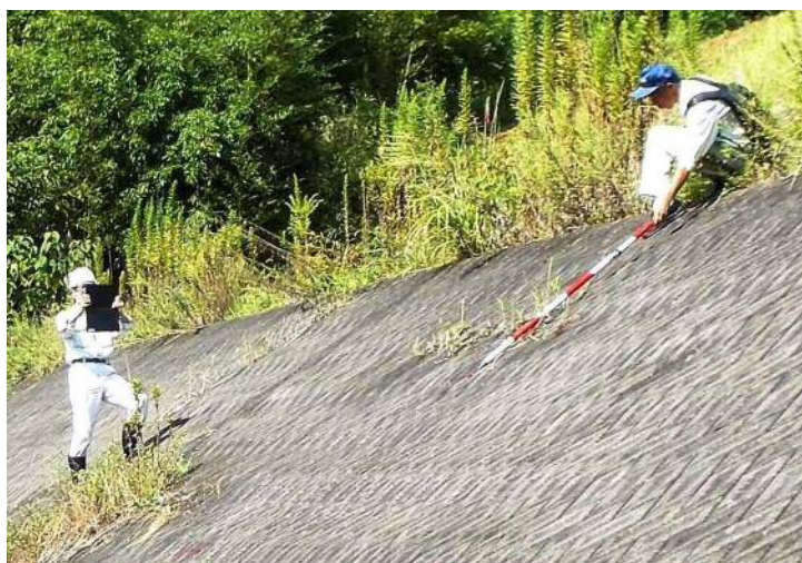
堤防点検状況
