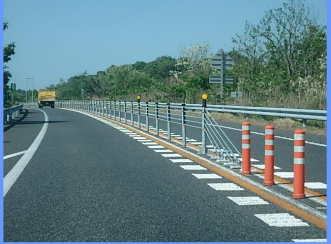
防護柵（ワイヤロープ）を設置することで、『車線のはみだし事故防止及び、ドライバー等への衝撃を大幅に軽減する』などの、安全性が向上します。
