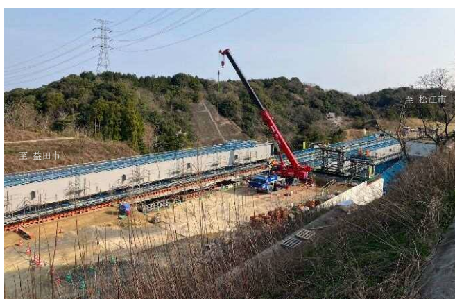
現在の施工状況 (令和5年3月撮影)
