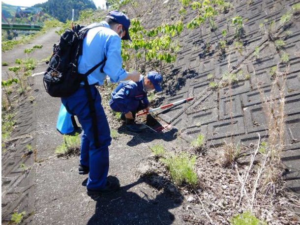
堤防点検の様子(江の川下流出張所管内)
