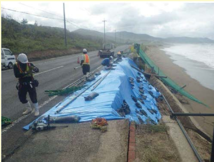
ブルーシート・土のう等設置 (島根県益田市：一般国道191号)
