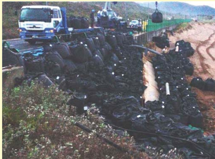
大型土のう等設置 (島根県益田市：一般国道191号)
