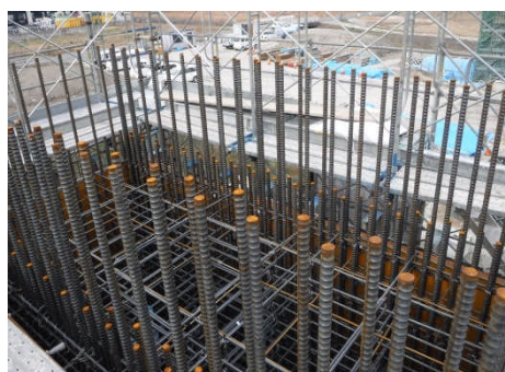
2月末(組立中の橋脚)
