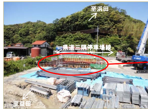
【三隅高架橋下部工事全景】
