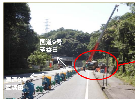
【板ヶ峠第1高架橋下部工事】
