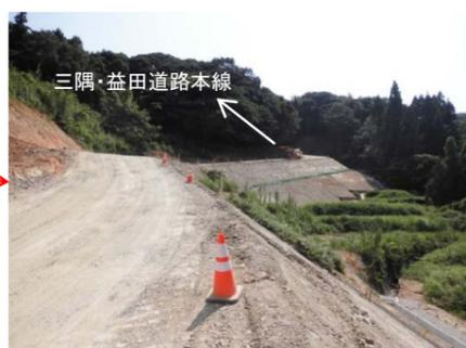
土田地区で施工中の工事用道路は、左写真にありますように、国道9号から山に向かって道路が出てくる様子をご覧になった方も多いと思います。右写真は工事用道路の様子です。土を運搬してきて、盛土で工事用道路を造っています。
