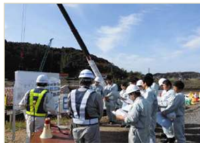
三隅川橋下部工事
