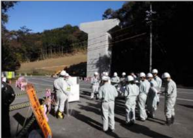
滝見高架橋下部工事
