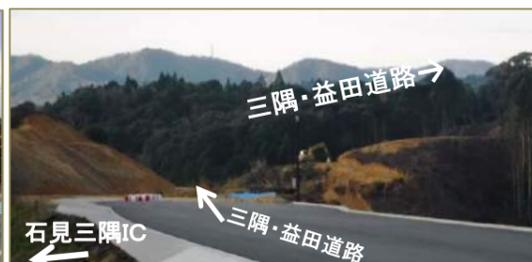
浜田・三隅道路に続けと、現在、石見三隅ICより西側の山を、古市場地区外伐採作業【施工:(株)毛利組】で伐木作業を、三隅地区改良工事【施工:今井産業(株)】で、切土・盛土工事を進めています。
