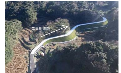
工事用道路(土田地区)【H29.2.2撮影】
