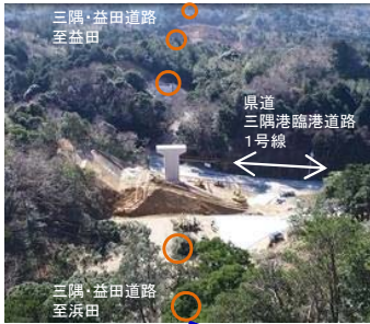
滝見高架橋【H29.2.3撮影】
