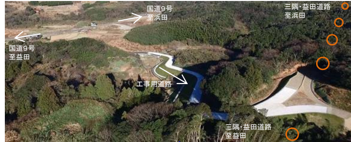
工事用道路(土田地区)【H29.2.2撮影】
