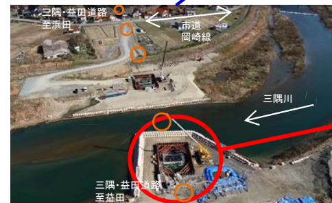
三隅川橋【H29.2.3撮影】
