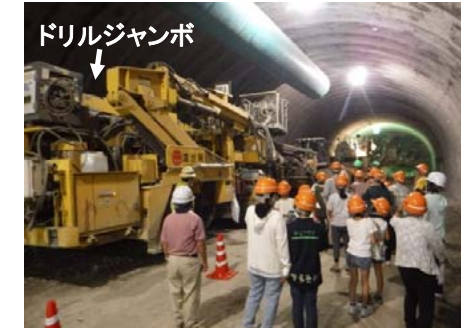
ドリルジャンボ トンネルの坑内で建設機械(ドリルジャンボ)の説明をしています。
