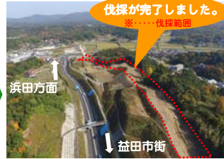
施工中（平成29年11月）
