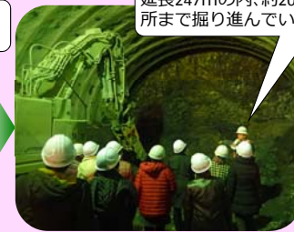
トンネルの施工状況を説明
