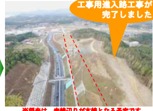
工事完了（平成30年2月）
