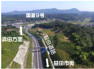
工事着手前（平成29年8月）
