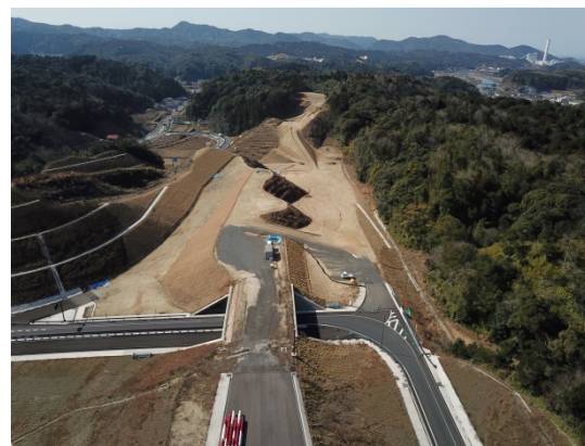
石見三隅 I C 整備状況 (益田方面を望む)
