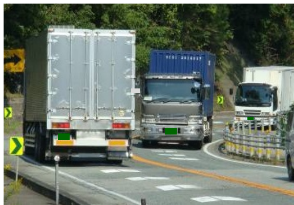
国道9号現況写真(線形不良箇所)
