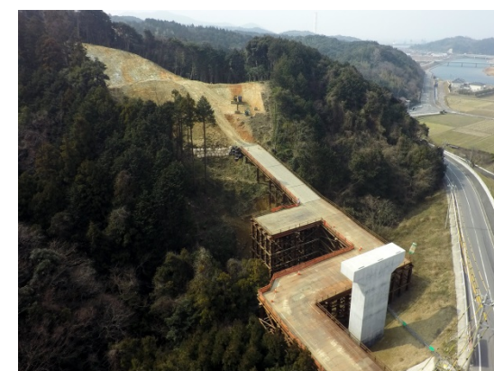
古市場第2高架橋 整備状況 (益田方面を望む)
