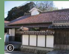
江戸時代初期から回槽車で栄えた高く積まれた棟瓦が特徴です。
