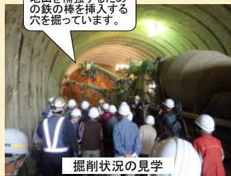
掘削状況の見学
