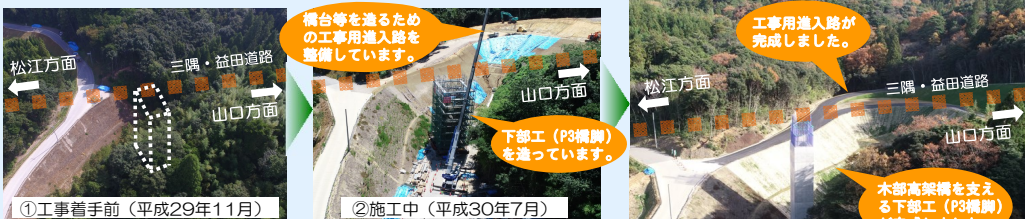
①工事着手前(平成29年11月)
