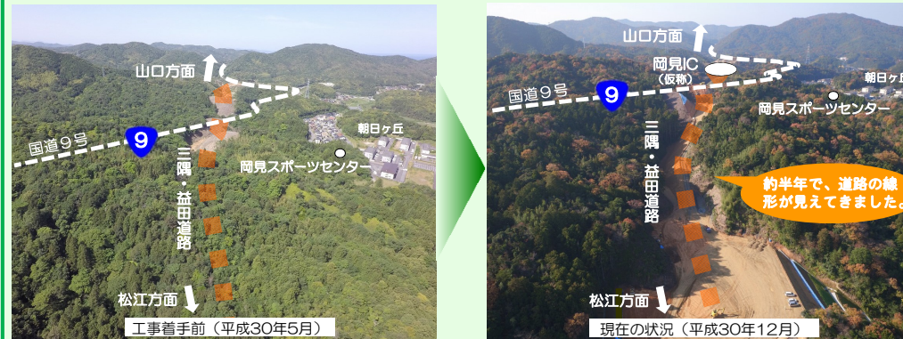
工事着手前(平成30年5月)
