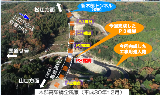
木部高架橋全風景(平成30年12月)
