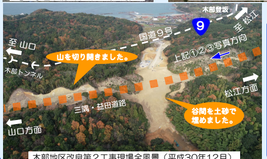
木部地区改良第2工事現場全風景(平成30年12月)
