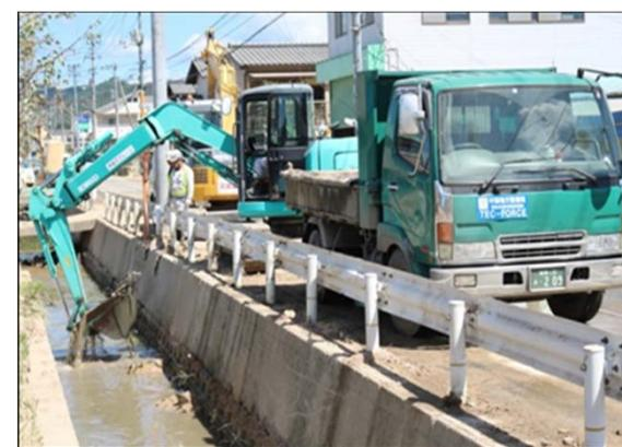
水路内に堆積した土砂撤去を実施
