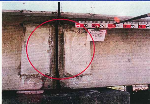
PC桁横締め定着部
