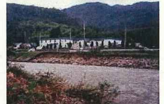
平成10年10月洪水 河岸侵食箇所 (三朝町)
