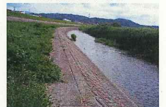
対策事例 (侵食対策のための低水護岸)
