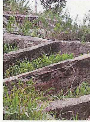
劣化したのり枠のモルタル片
