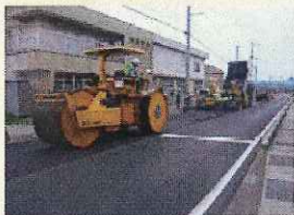
切削オーバーレイによる補修
