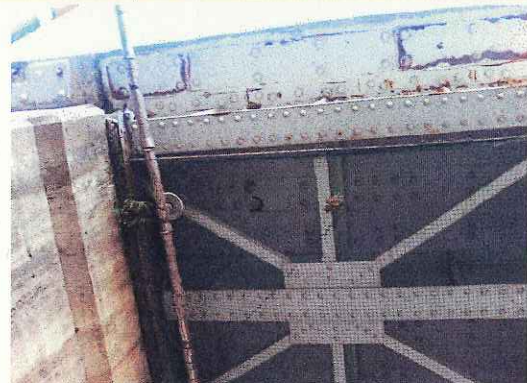
ボルト抜け落ち対策の例
