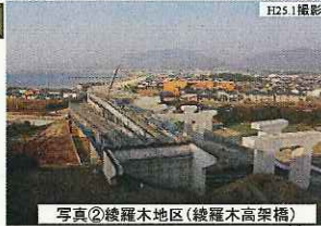
写真②綾羅木地区(綾羅木高架橋)
