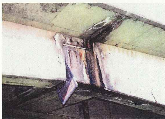
主桁、掛け違い部、目地板
