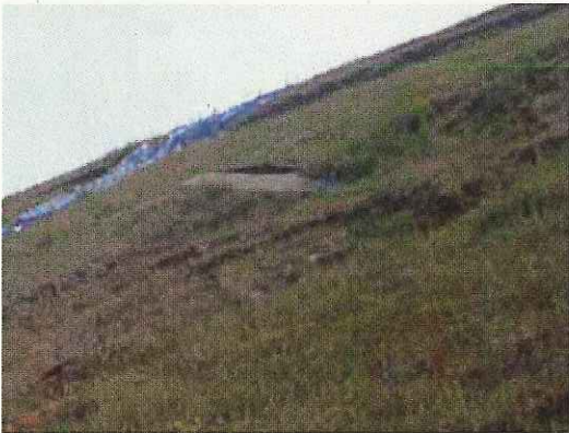
のり面全体に崩壊が生じている例
