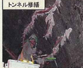
ひび割れ注入による補修
