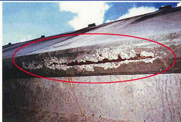
床版(張り出し部)
