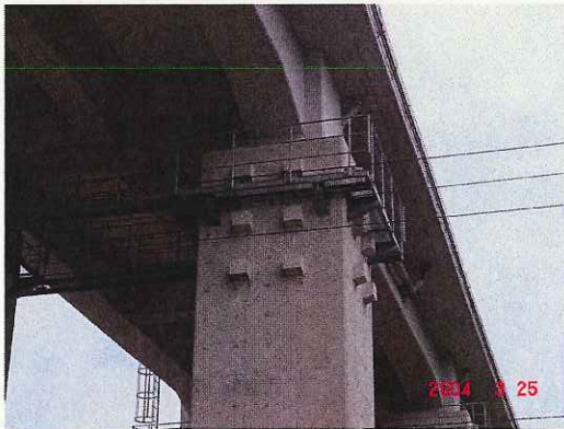
上部構造検査路
