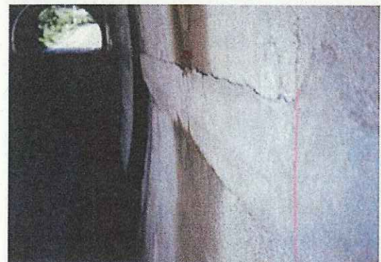
逆巻き工法の縦断方向打ち継目と化粧モルタル
