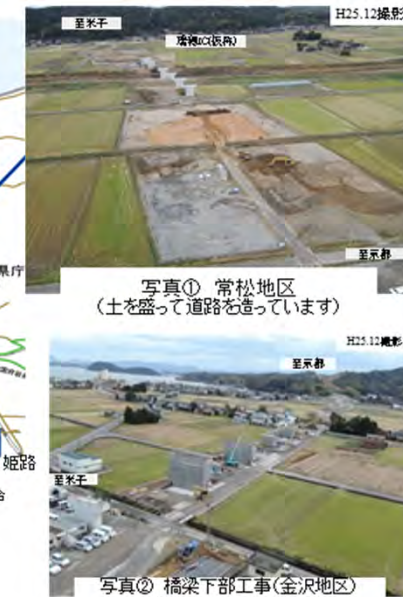
写真② 橋梁下部工事(金沢地区) (橋の脚を造っています)
