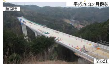
写真③ 折居川橋上部工事の施工状況 (コンクリート製の橋を架けています)
