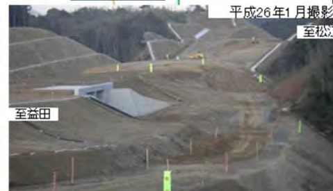
写真② 力石地区改良工事の施工状況 (道路の高さまで山を切り、土を盛っています)
