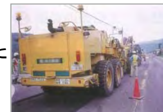
路面切削作業
