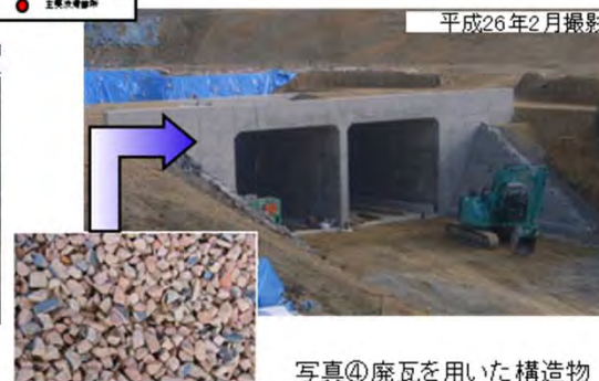
写真④ 廃瓦を用いた構造物 (廃瓦をコンクリートの材料として利用します)
