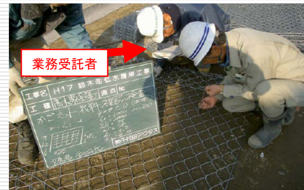
(河川護岸用かごマットの材料確認)
