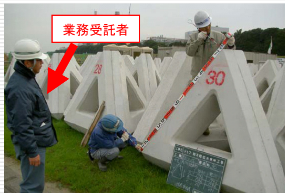
(根固めブロックの材料確認)
