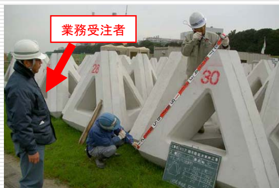
(根固めブロックの材料確認)
