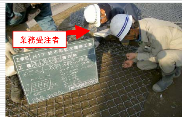
(河川護岸用かごマットの材料確認)
