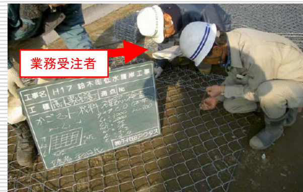
(河川護岸用かごマットの材料確認)
