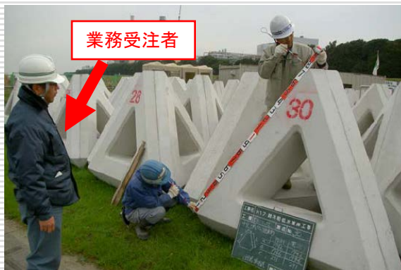
(根固めブロックの材料確認)
