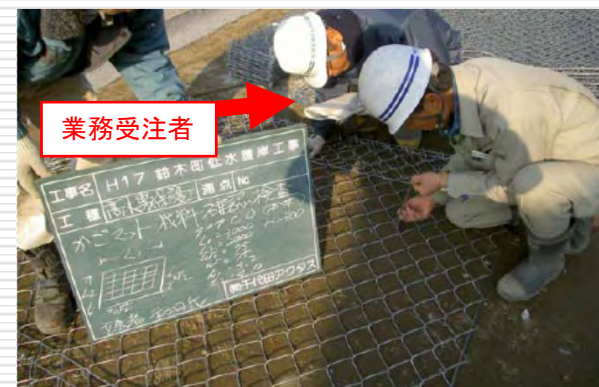
(河川護岸用かごマットの材料確認)
