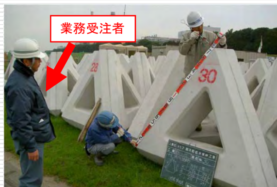
(根固めブロックの材料確認)
