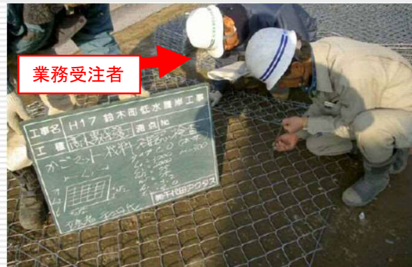
(河川護岸用かごマットの材料確認)
