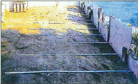
ストリップ設置状況
