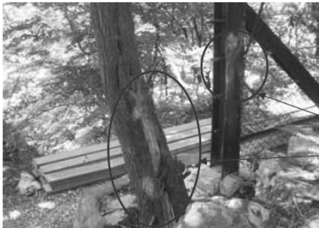
写真② 軌道側 既設落石防護柵損傷
