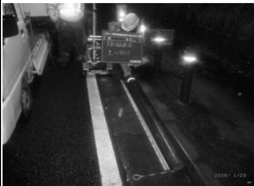
切断された支柱の写真
