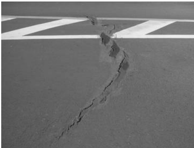
クラック発生状況写真
