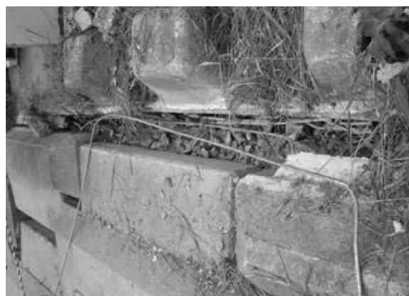
天端鋼線結線状況 コの字に差し込んであるだけであった。
