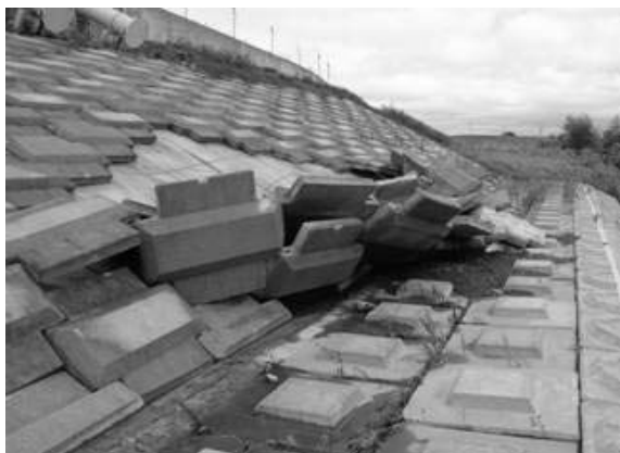
護岸めくり上がりの状況 全景
