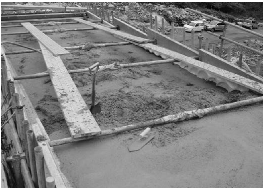
骨材寸法25mm打設状況
