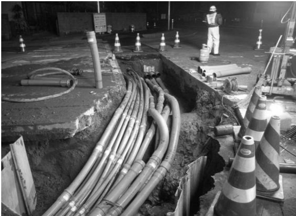
埋設管路の様子
