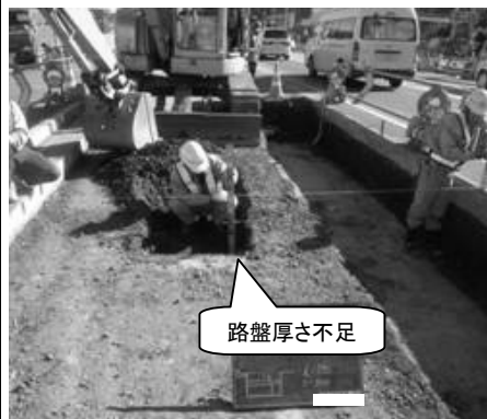
出来形不足状況写真
