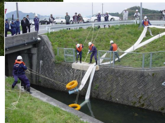
ポンプの設置作業
