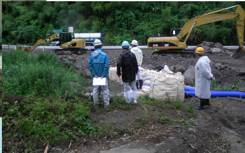
真野2号砂防堰堤の除石工事のパトロール状況
