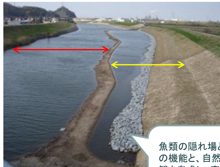
施工直後(平成25年4月)
