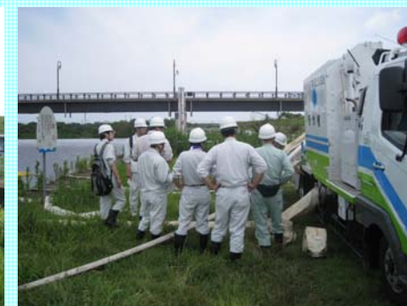
排水ポンプ車の構造を確認している状況
