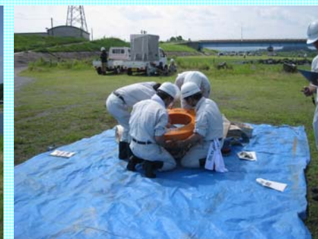
排水ポンプ設置訓練状況
