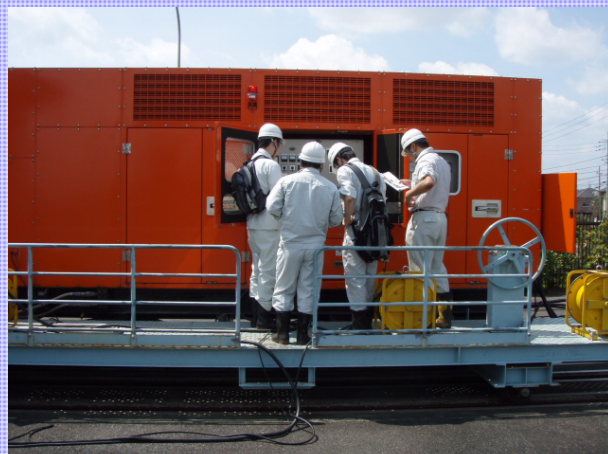
皆生排水機場の訓練状況
