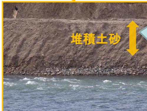
堆積土砂は掘削しながらふるい分け、粒の小さい砂(海岸砂程度)は下流側に「置き土」します。粒の大きい砂と石は深く掘れている箇所に入れます。
