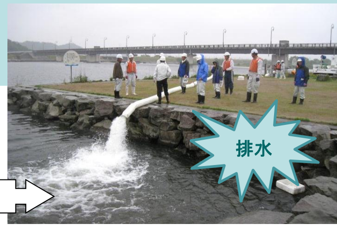
排水ポンプ設置
