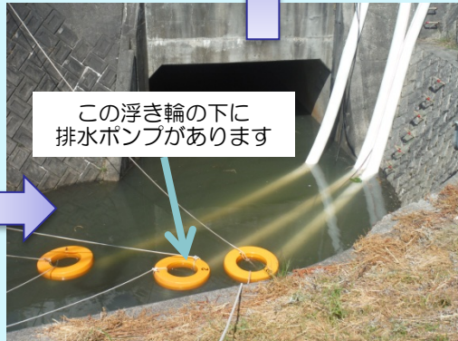
クレーンを使わず人力で据付けできます
