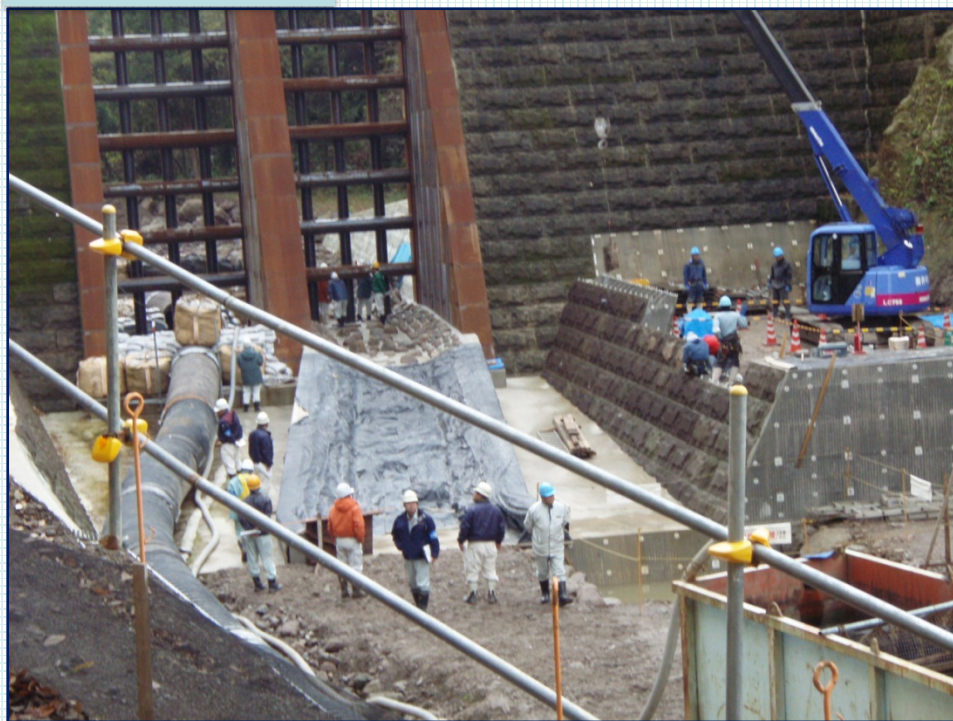
対象現場 大山砂防林ヶ原砂防堰堤第2工事
