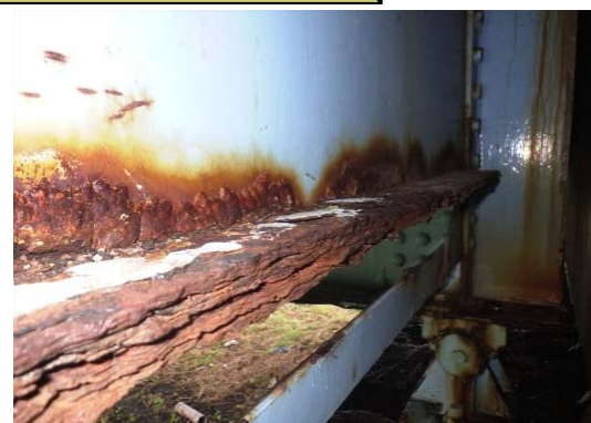
損傷状況(部材の断面欠損)
