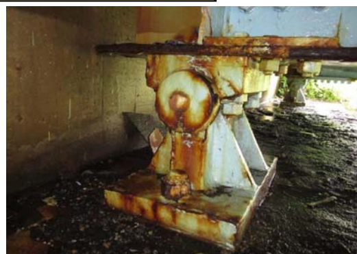
損傷状況(部材の断面欠損)
