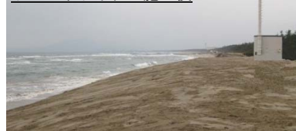
サンドリサイクル施工後
