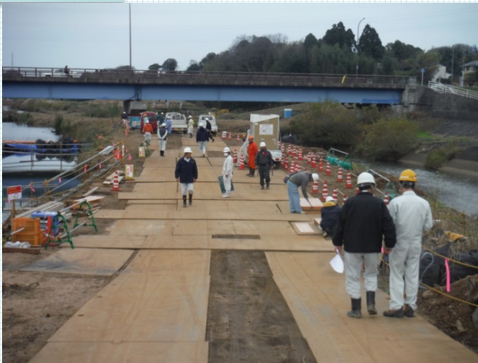
対象現場 法勝寺川青木地区護岸整備他工事
