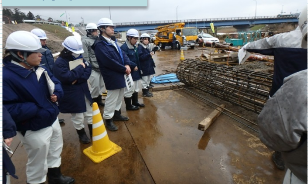
対象工事：法勝寺川四ヶ村堰改築工事
