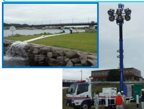
排水ポンプ及び照明車 設置完了！
