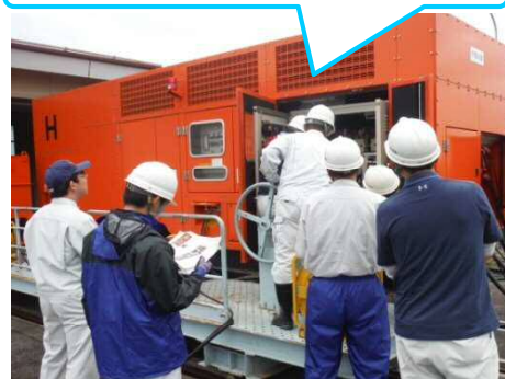
ポンプ操作盤内ブレーカ投入中
