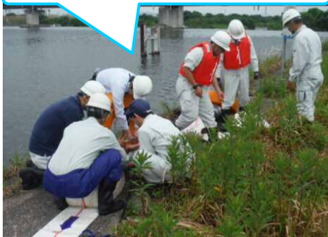
排水ポンプ設置訓練中
