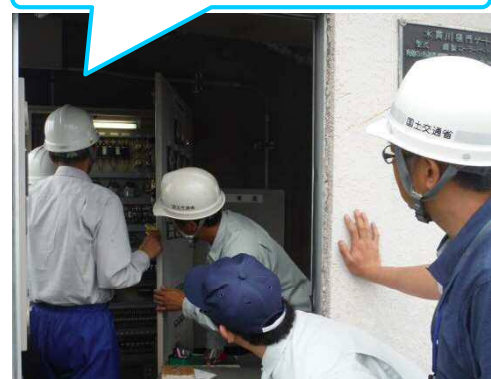
樋門操作盤内ブレーカ復旧訓練中
