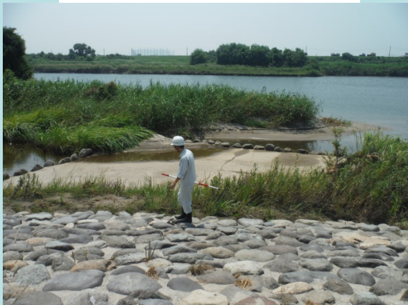
日野川堰巨石張り石の点検
