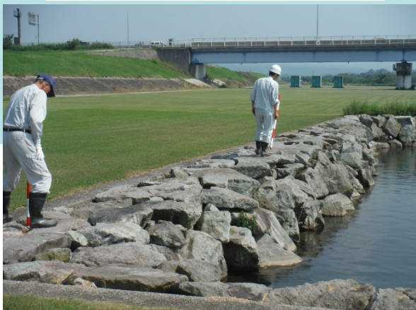
日野川堰巨石張り石の点検
